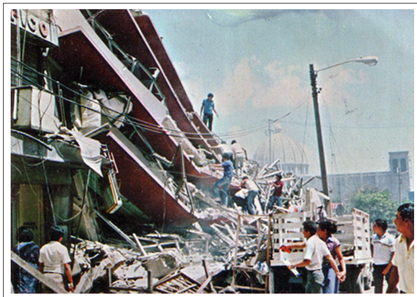
12 Edificio Dario. Terremoto del 10 de octubre de 1986. http://www.flickr.com/photos/reneaguiluz/3691168496/in/photostream/ . Consultado 28/11/2009
