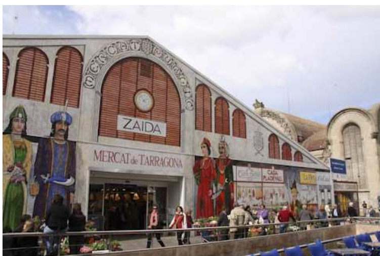
Figura 3: Fachada del Mercado de Tarragona, Cataluña, España.
