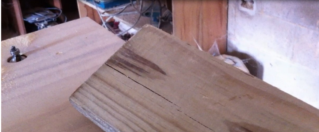
Grietas generadas en la madera al ser secada directamente al sol, lo cual se evita con el uso del colector solar
