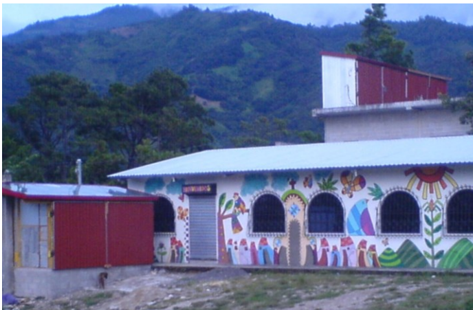
Ubicación de las tres cámaras de secado
