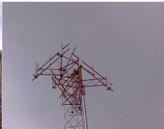
Figura 10. Vista Antenas de RF a 36 m, dos antenas por sector.
