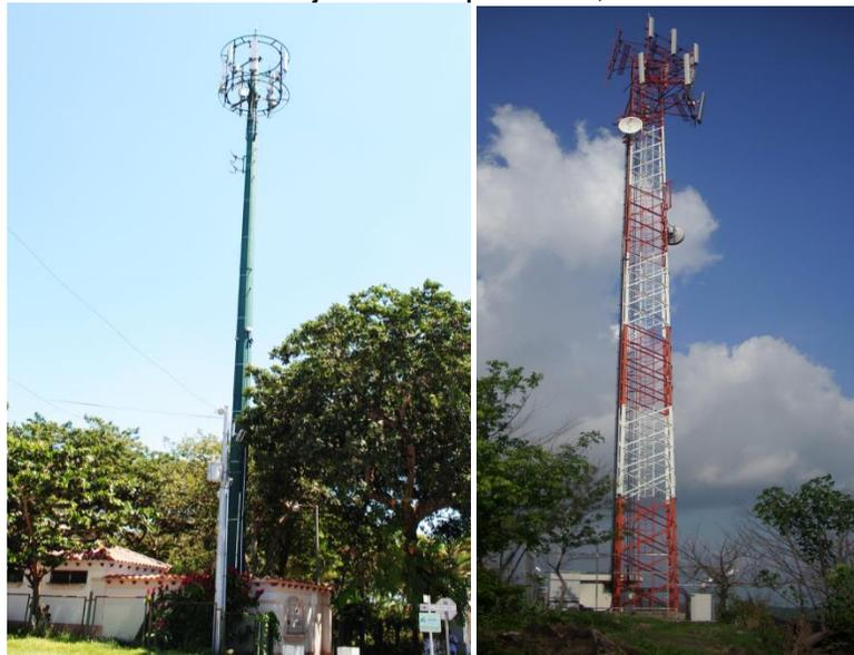
Figura 3. Tipos de estructuras Monopolo y triangular autosopotadas
