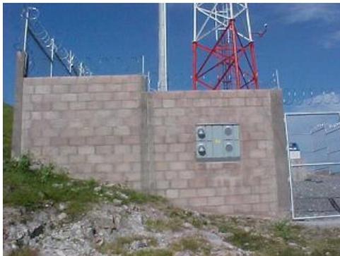
*Figuras 4.* Caja de medidores de 4 espacios control de energía por operador y control de luces de sitio
