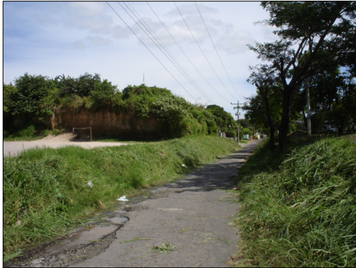
3 Vista general de la calle marginal de acceso al terreno.
