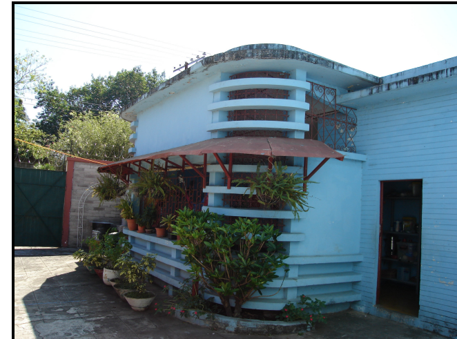
EXTERIOR SALA CUNA
