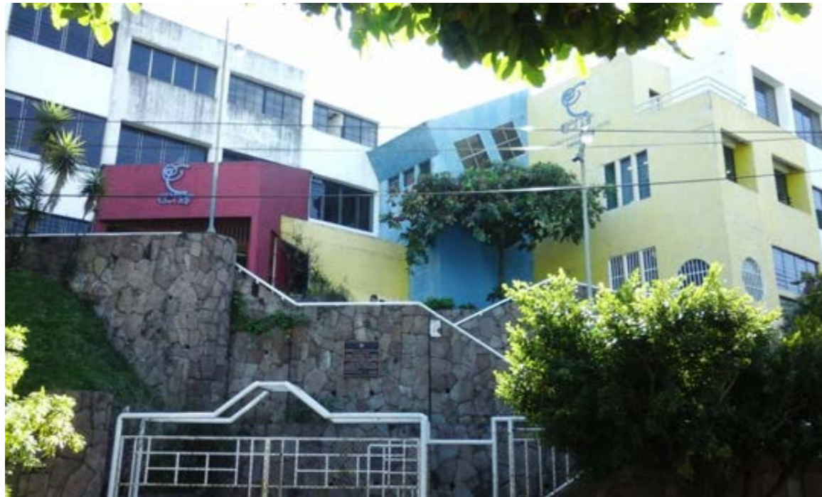
Fig.27: Fachada Principal del CENAR. Fotografía tomada por equipo de trabajo.
