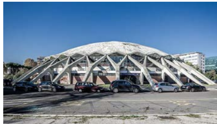
Fig. 167: Palacio del Deporte, Roma (1956–1957) (concreto 360 grados, 2016, párr.4)
