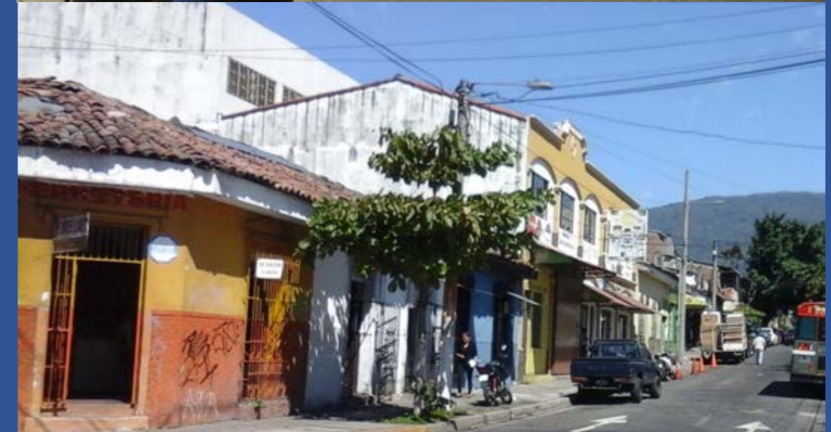
En la imagen construcciones existentes de bloque de concreto y ladrillo de barro.
