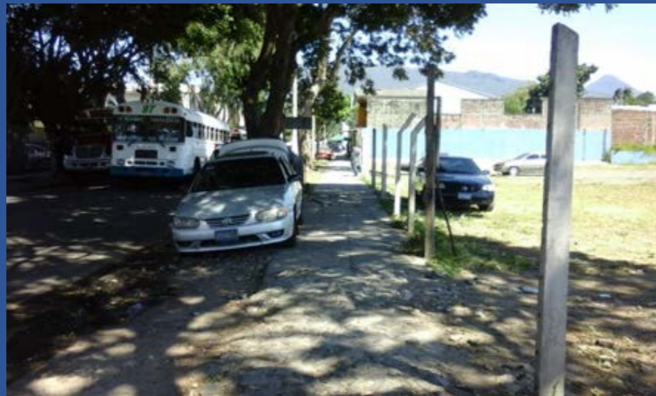
6 Avenida Sur, arriate, cordón y cuneta inexistente, aceras dañadas y acumulación de aguas.
