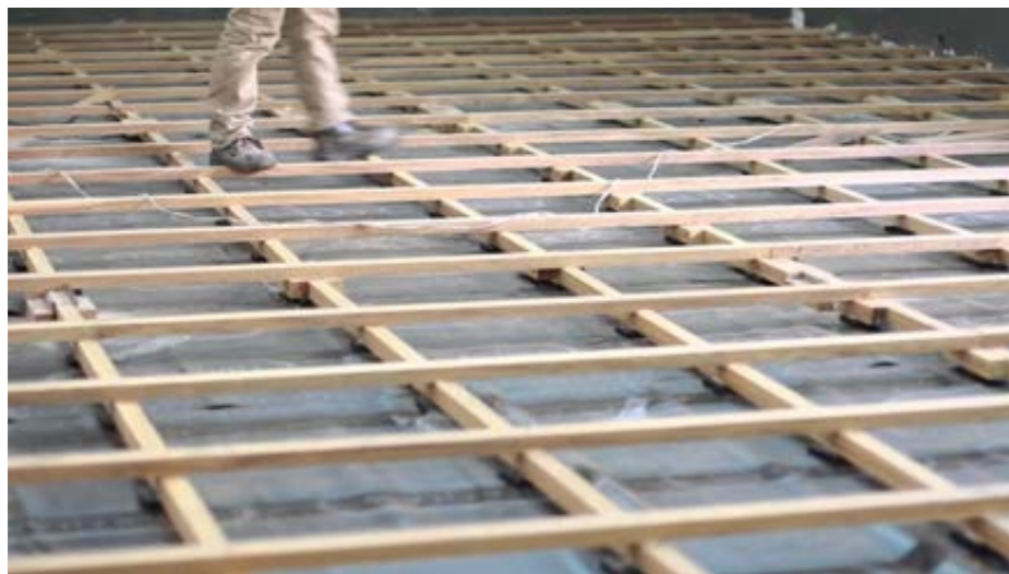
Entramado de 40*40cm de Revestimiento de pino seco sepillado
