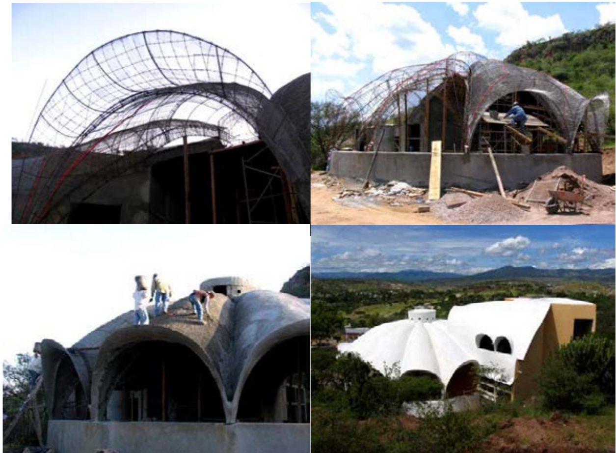
Fig. 129: Ejemplo sistema ferrocemento. (arquimaster, 2014, escuela secundaria técnica)
