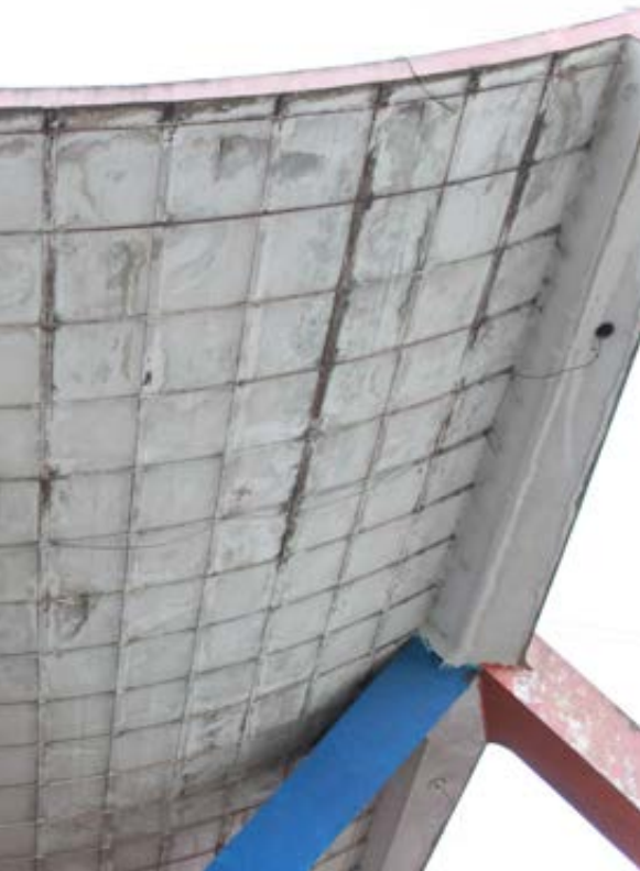
Fotografía 2. Cubierta de tribuna, lado derecho.
