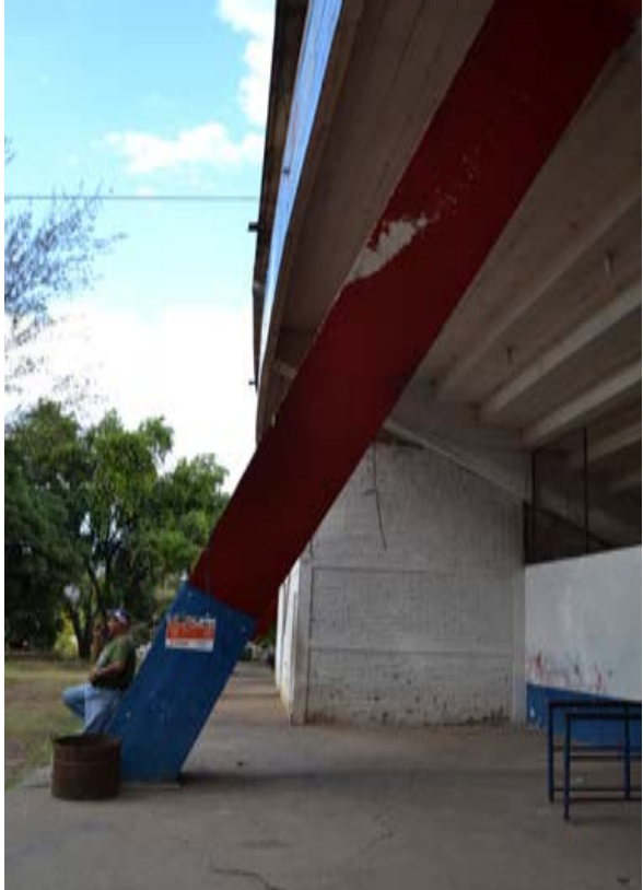
Fotografía 3. Columna 4 lateral Derecho.
