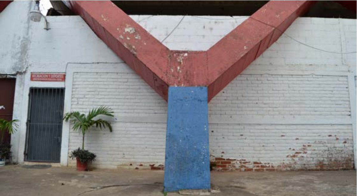
Fotografía 1. Columna 2 de la fachada principal.
