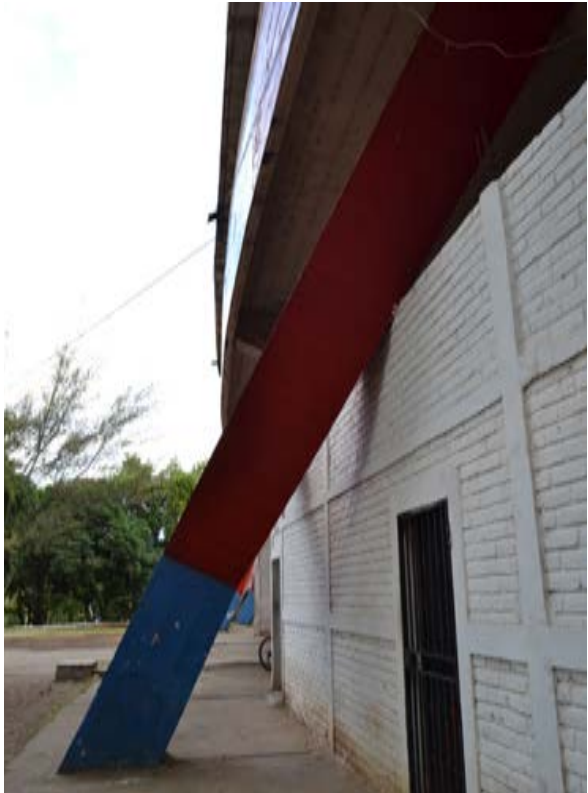
Fotografía 3. Columna 6 lateral Derecho.
