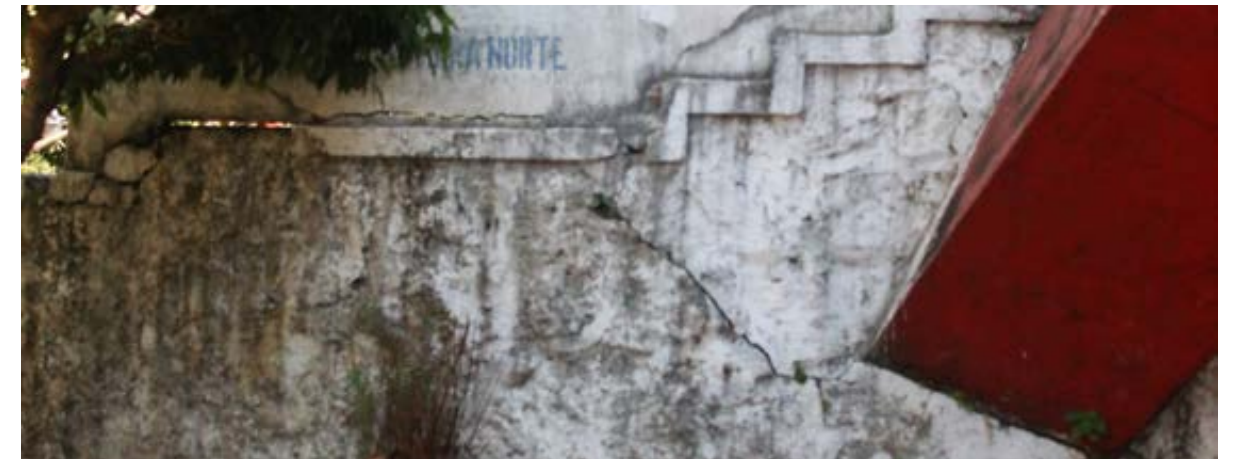
Fotografía 2. Unión de columna 1 a gradas de acceso del portón #8.
