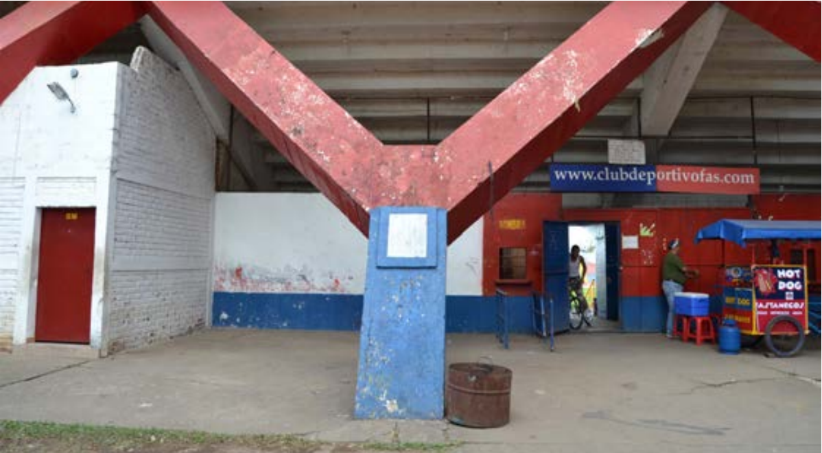
Fotografía 1. Columna 4 de la fachada principal.
