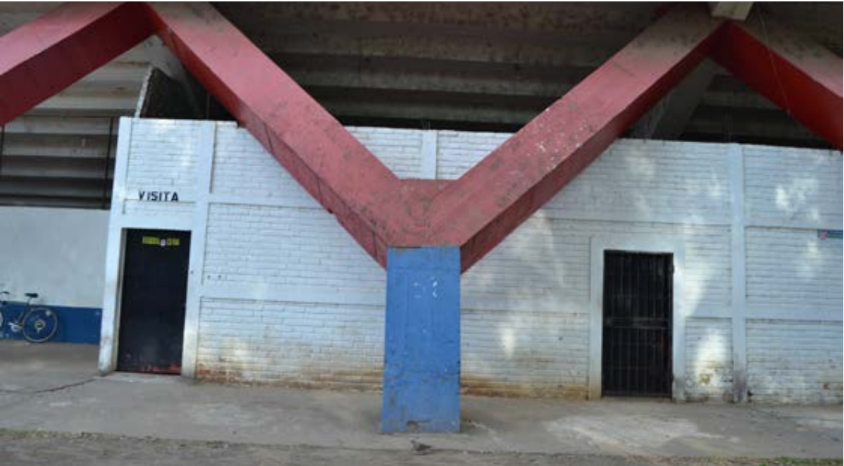
Fotografía 1. Columna 6 de la fachada principal.
