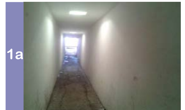
Vista de tunel desde el interior.
