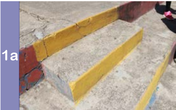
Vista gradas circulación vertical.
