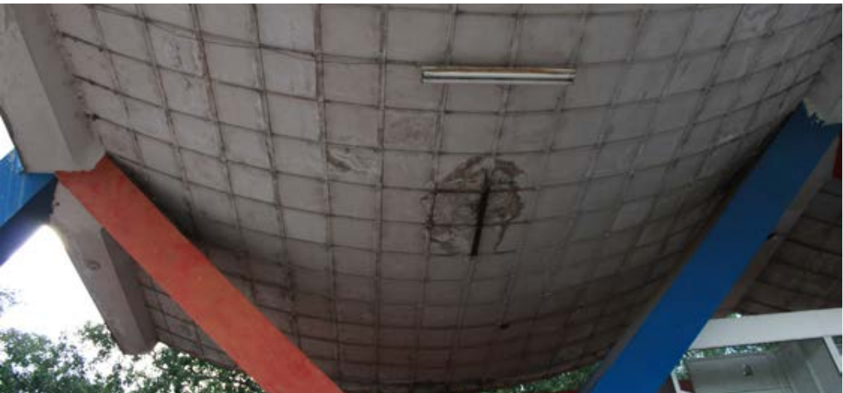
Fotografía 1. Cubierta de tribuna, lado izquierdo.
