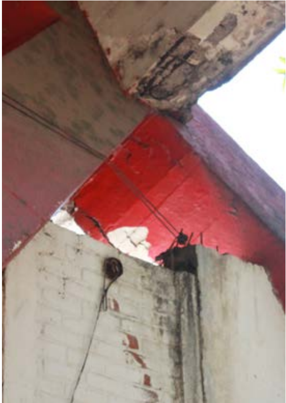
Fotografía 3. Columna 2 lateral Derecho.
