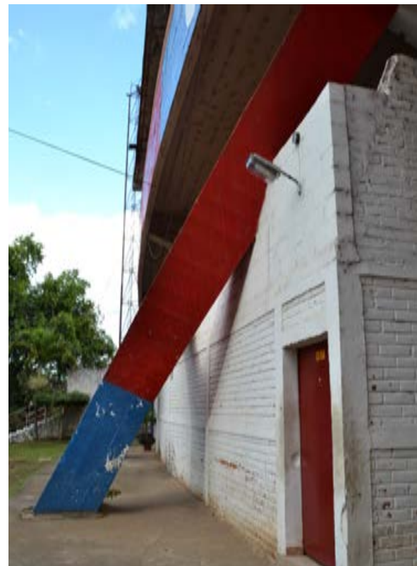
Fotografía 3. Columna 3 lateral Derecho.
