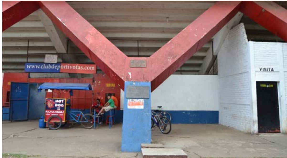
Fotografía 1. Columna 5 de la fachada principal.
