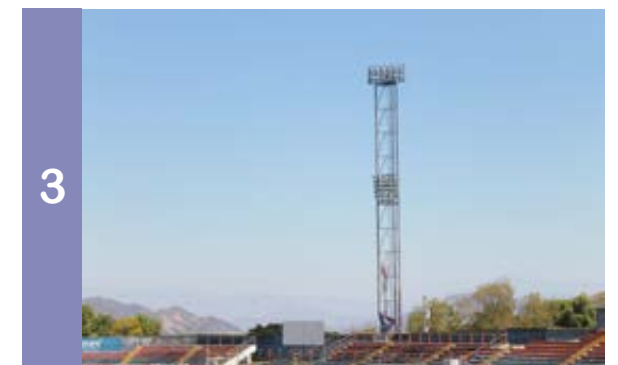
3 Vista de torre de iluminación.
