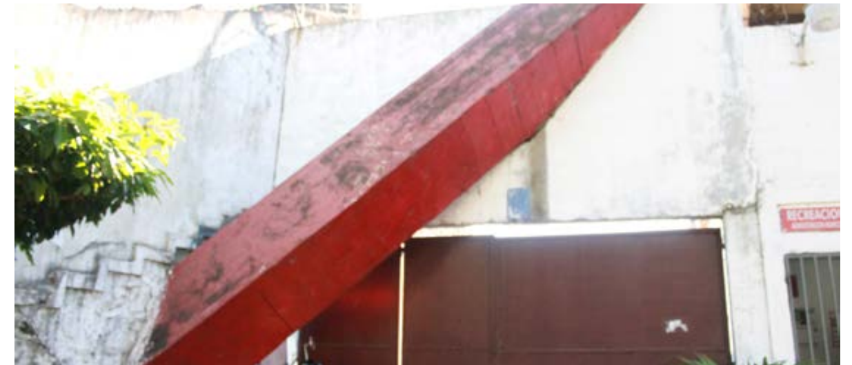
Fotografía 1. Columna 1 de la fachada principal.
