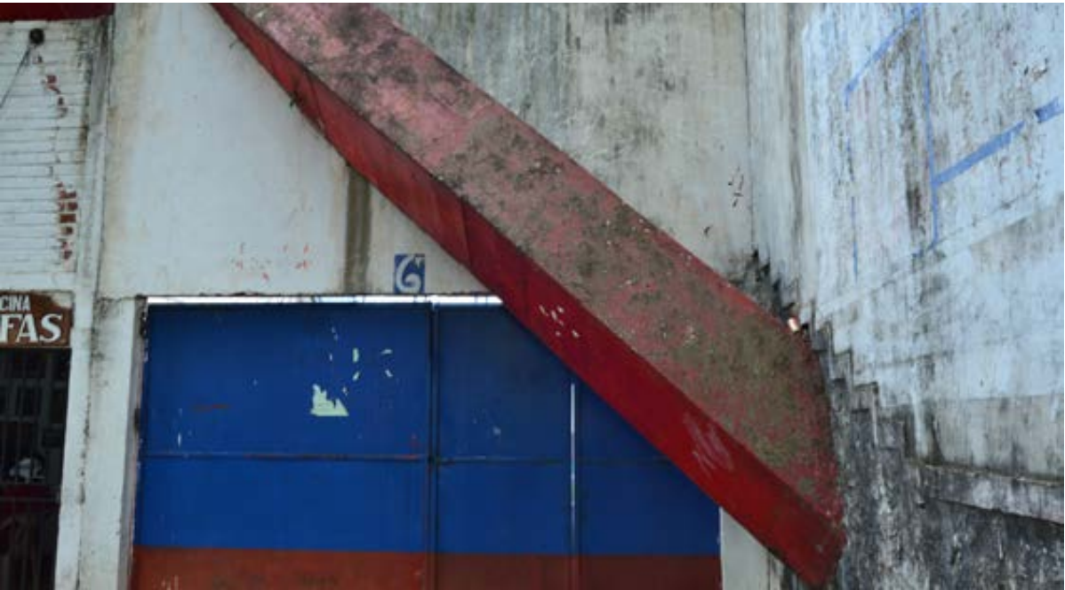
Fotografía 1. Columna 2 de la fachada principal.
