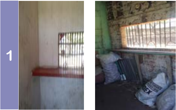
Vista interior taquillas del área de sol.
