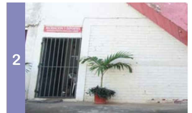
2 Vista exterior oficinas administrativas.
