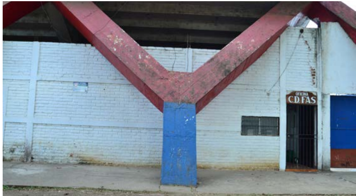
Fotografía 1. Columna 7 de la fachada principal.
