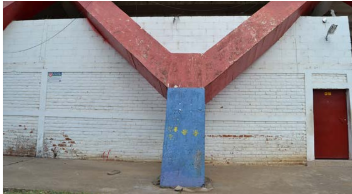
Fotografía 1. Columna 3 de la fachada principal.
