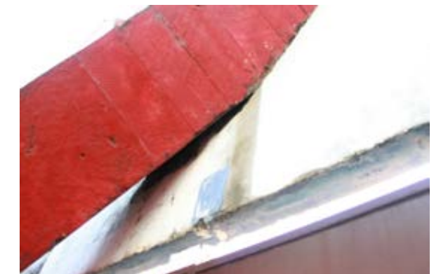
Fotografía 4. Unión a pared de la fachada del estadio.
