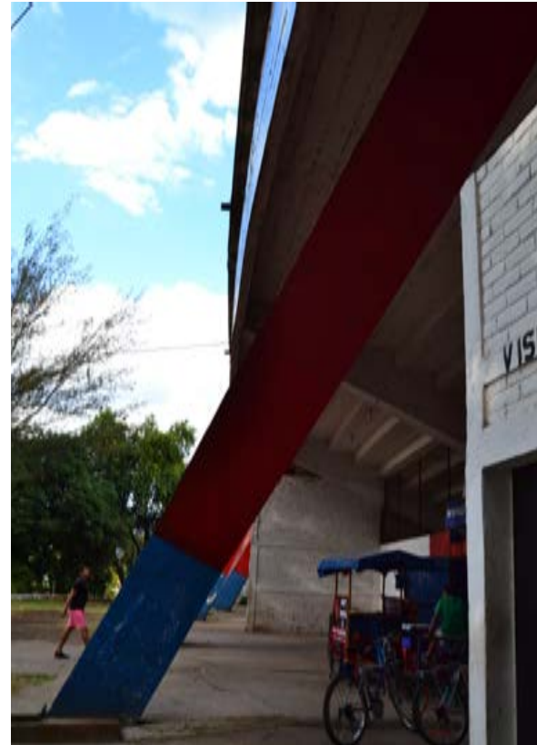
Fotografía 3. Columna 5 lateral Derecho.
