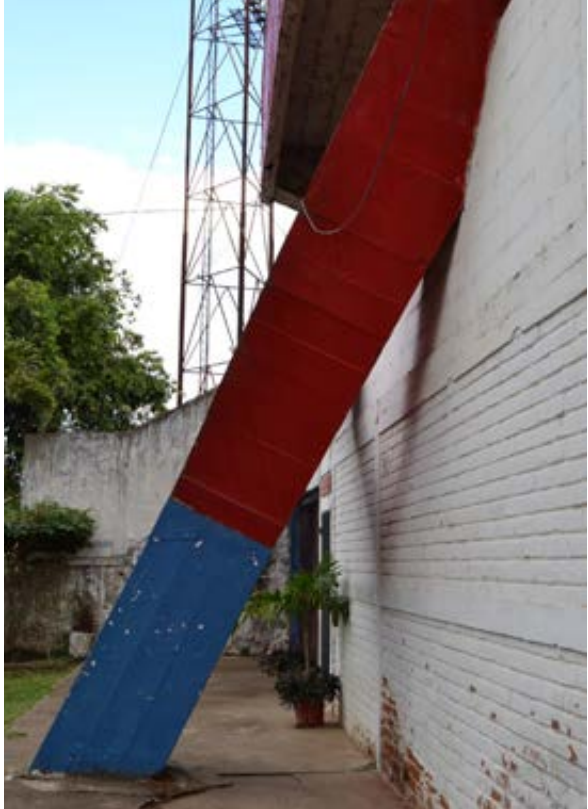
Fotografía 3. Columna 2 lateral Derecho.
